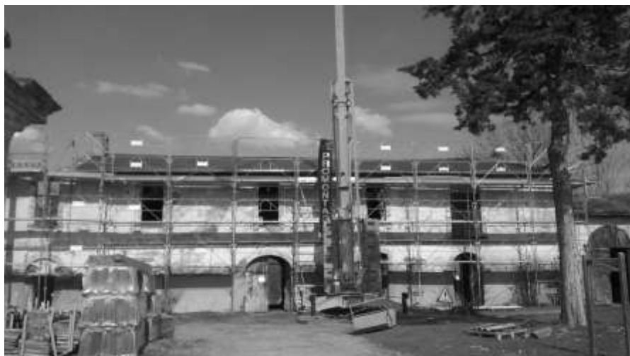
Toitures des communs en cours de restauration
